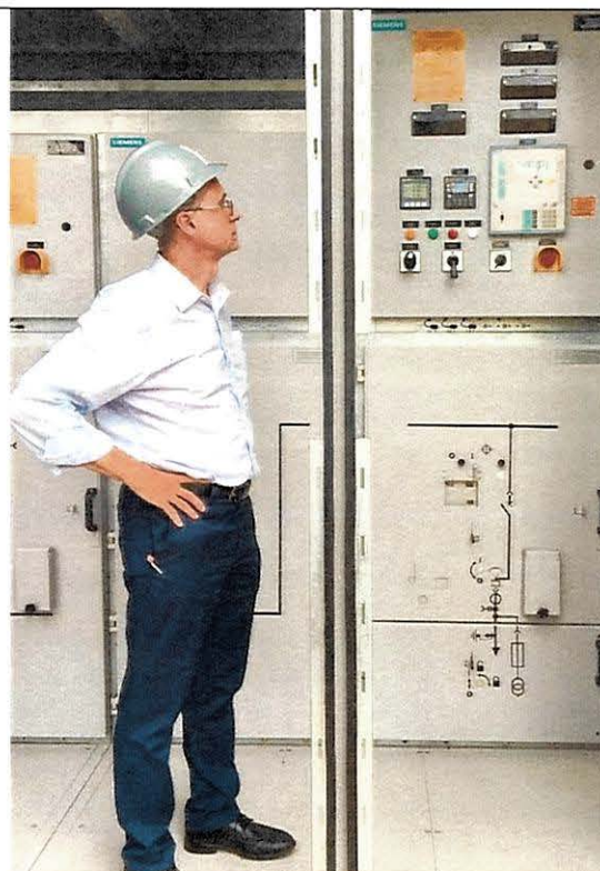
Foto 8: Cubículos de 13,8 kV, da subestação do CEPEL na Unidade Adrianópolis, adquiridos no âmbito do Projeto META.
